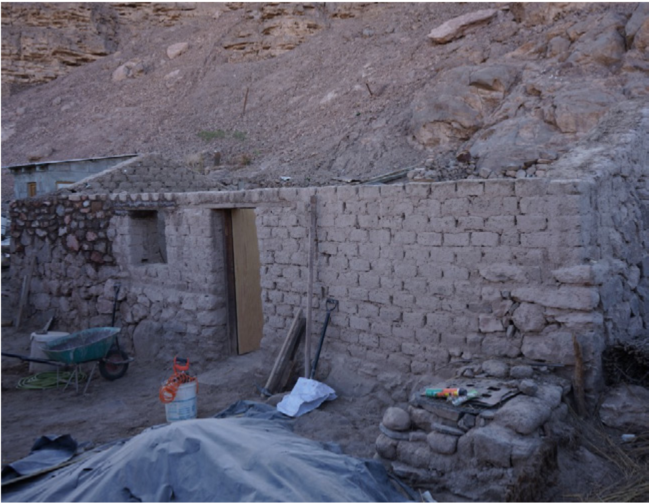
Muro de fachada frontal con mampostería de piedra reestructurado.
