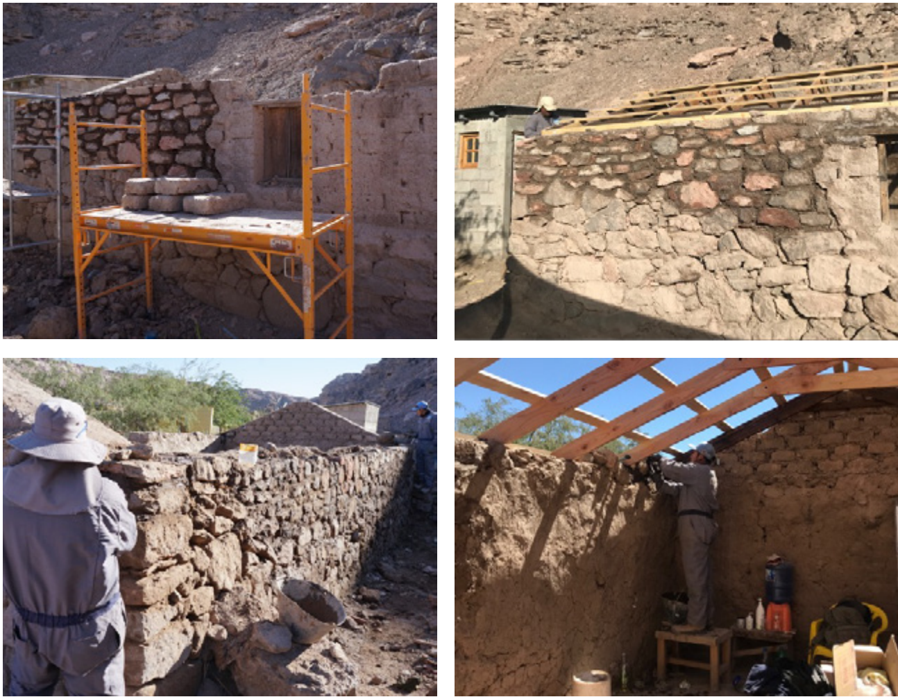
Consolidación de muros en fachadas exterior, interior y coronación de muros.
