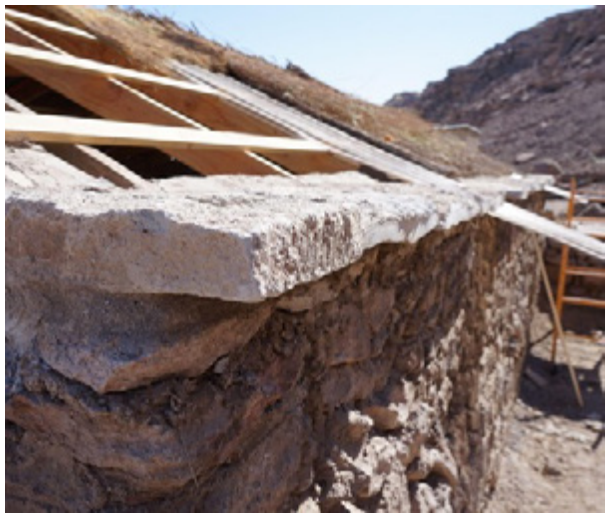
Restitución de estructura de cubierta, costaneras y brea.
