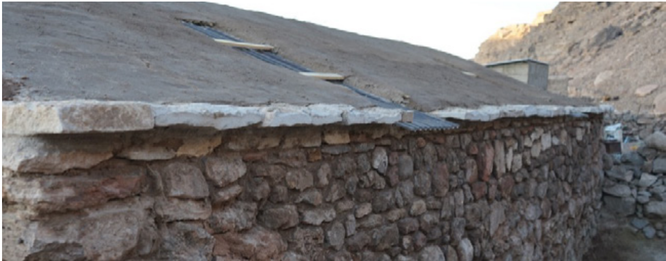
Integración de geomalla, fieltro impermeabilizante y restitución de torta de barro.
