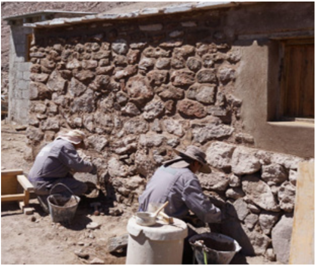
Inyección de morteros de barro y restitución de revoques en sus cuatro fachadas.
