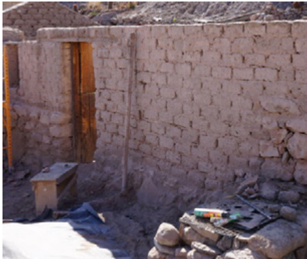
Brea retirada de cubierta y liberación de revestimiento exterior en muro de adobe.
