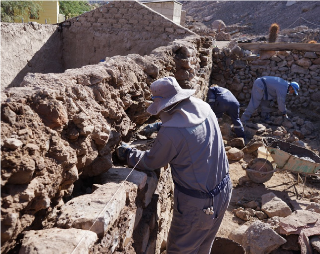
Muro de piedra tipo cajón con núcleo de tierra.
