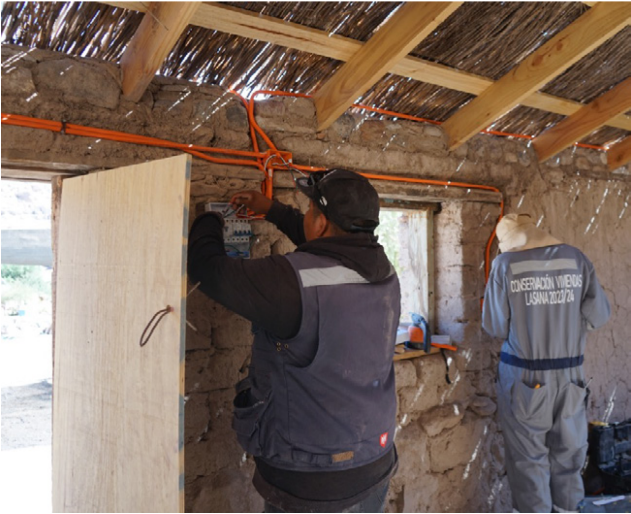
Revisión y mejora de instalaciones, incorporación de circuito eléctrico interior y exterior.
