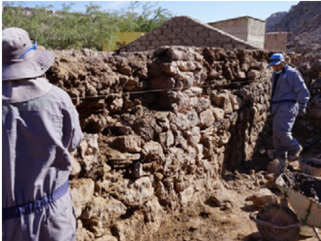
Desarme de muro cajón posterior de vivienda, para en una próxima partida consolidar estructura.
