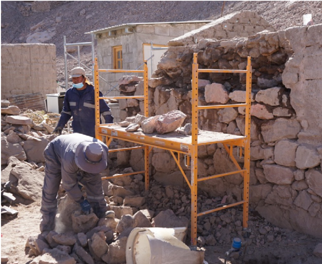
Desarme parcial de muro de piedra rústica con disposición irregular.
