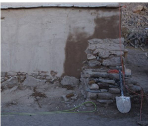
Proceso de aplicación de morteros y consolidación de asador.
