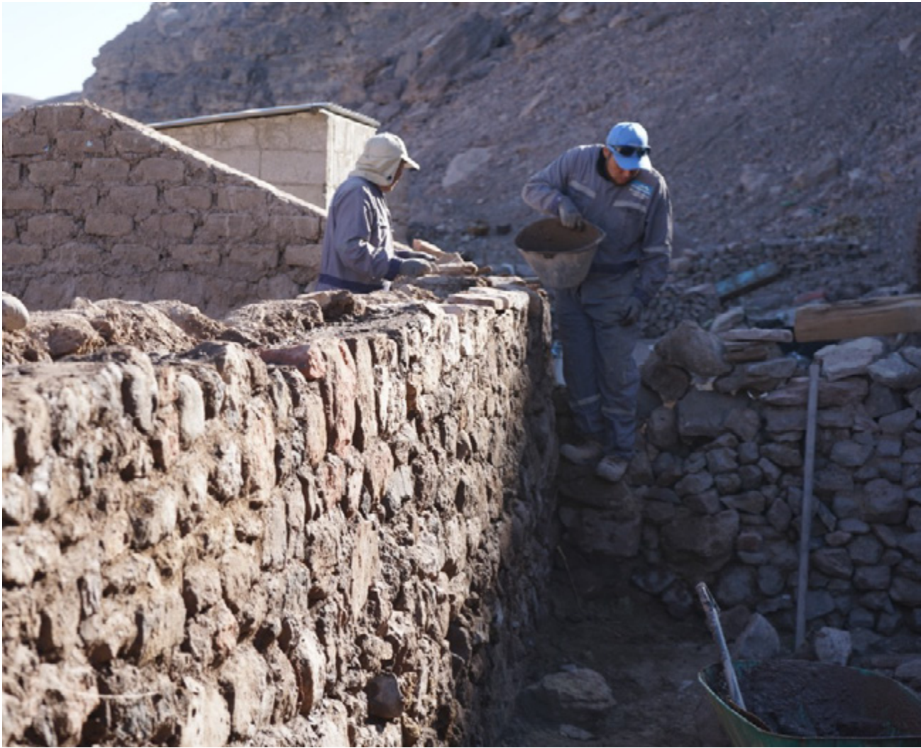
Consolidación de estructura de muros con morteros de barro.
