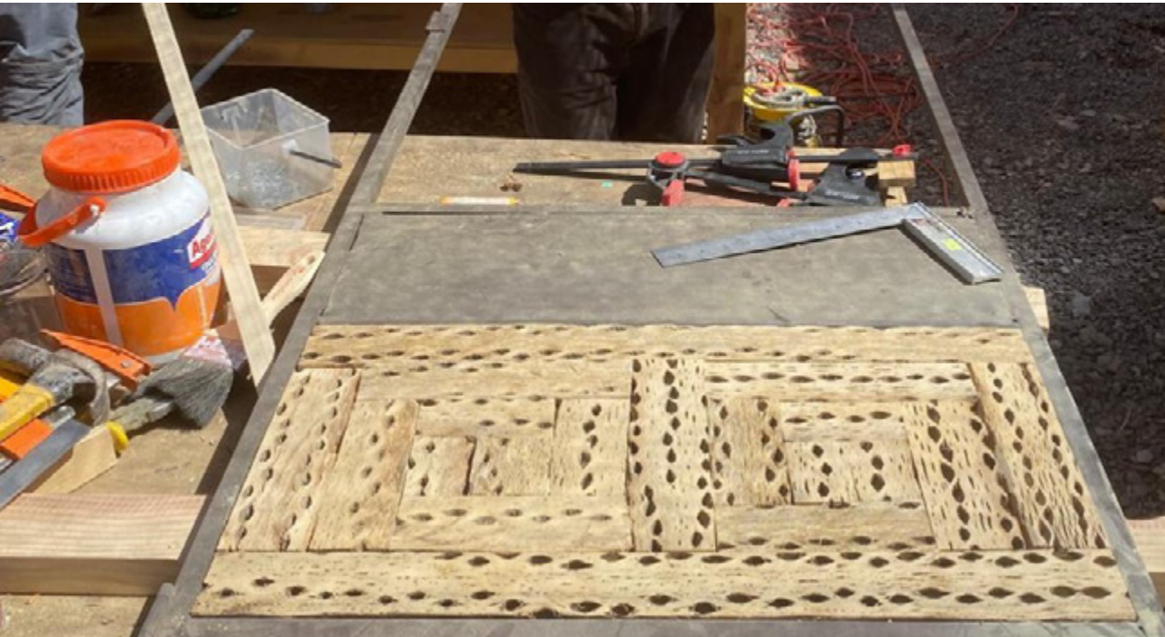
Proceso de restauración de mosquitero en escuela taller con integración de madera de cactus.
