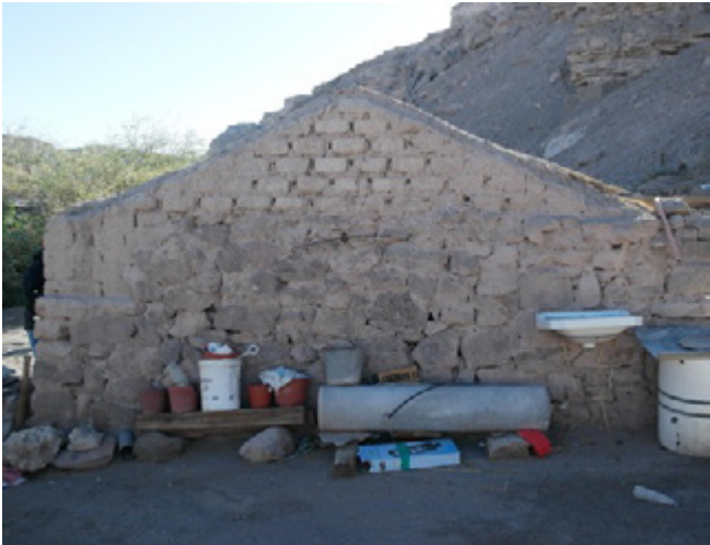
Desarme de muro cajón posterior de vivienda, para en una próxima partida consolidar estructura.
