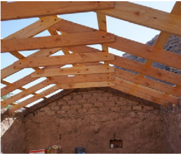
Restitución de la armadura de techumbre de la vivienda.
