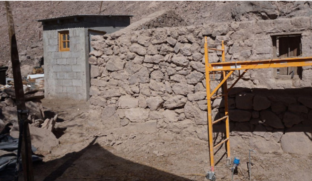
Liberación de morteros envejecidos en fachada construida con piedra y morteros de barro.
