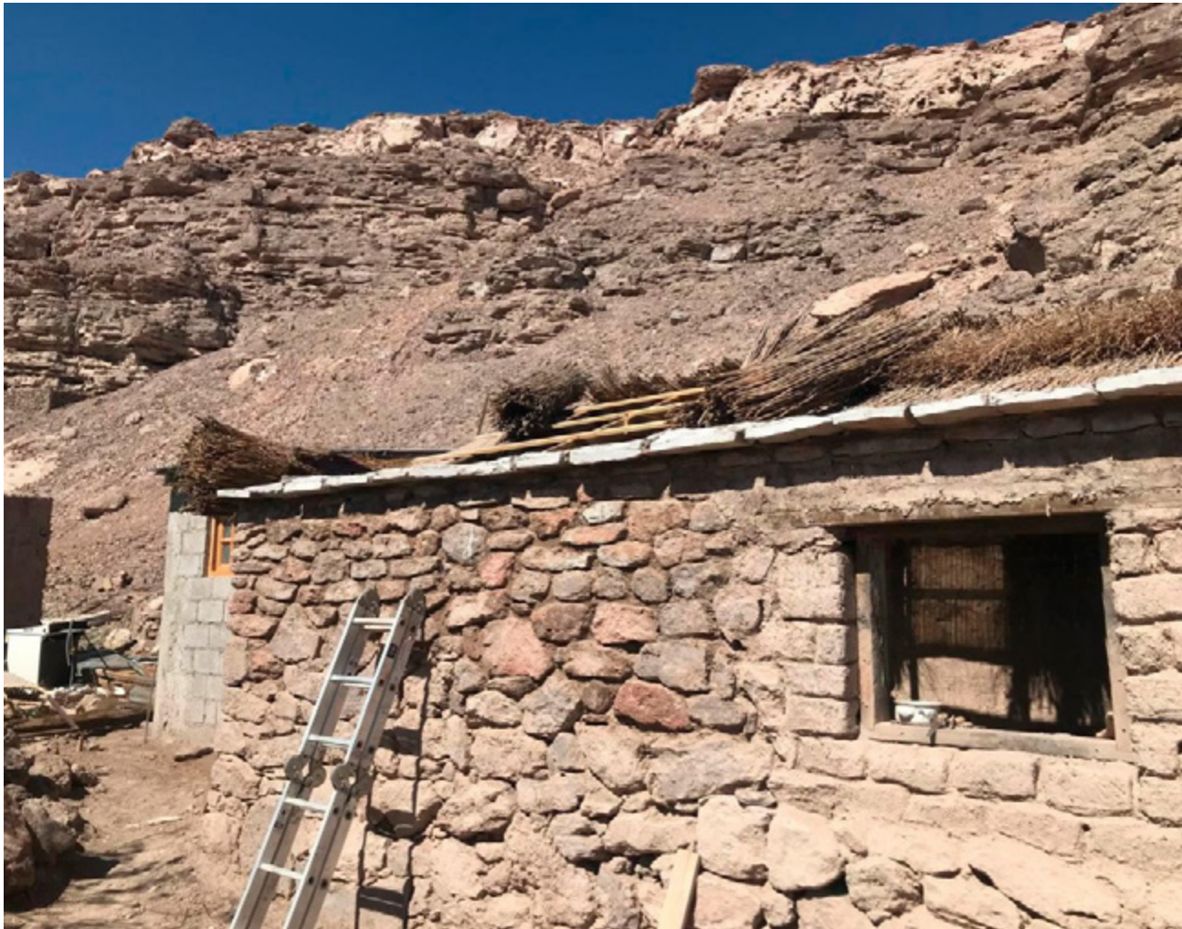
Proceso de restitución de la cubierta original.
