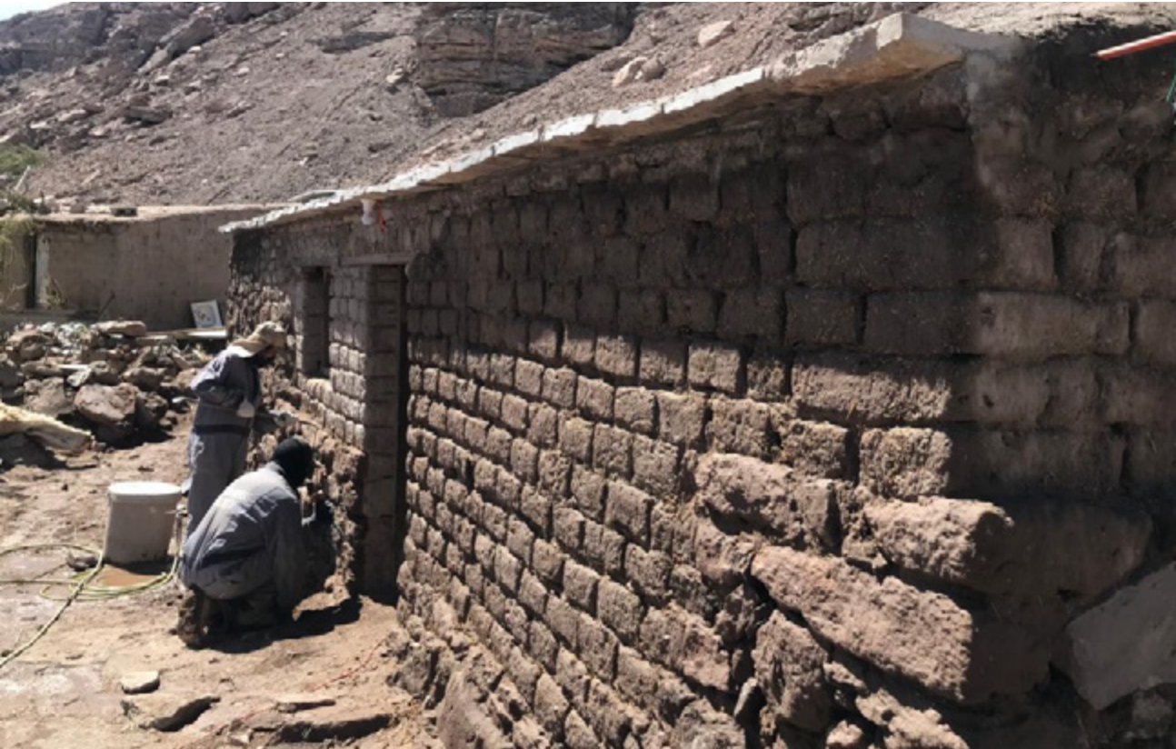
Limpieza de superficie para remover residuos que puedan interferir en la restitución de revoques.
