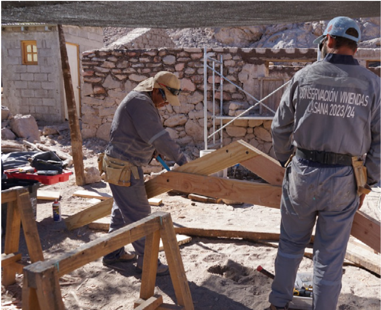
Fabricación de viga par y nudillo, unión de ensambles encolados a media madera reforzados.
